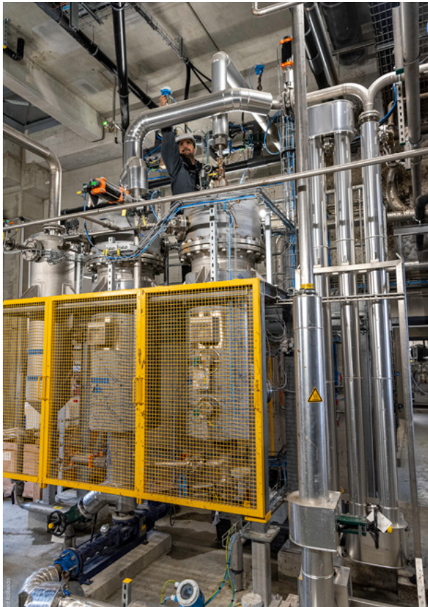
Réacteurs d'hydrolyse et de détente flash de l'unité pilote de Seine Valenton
