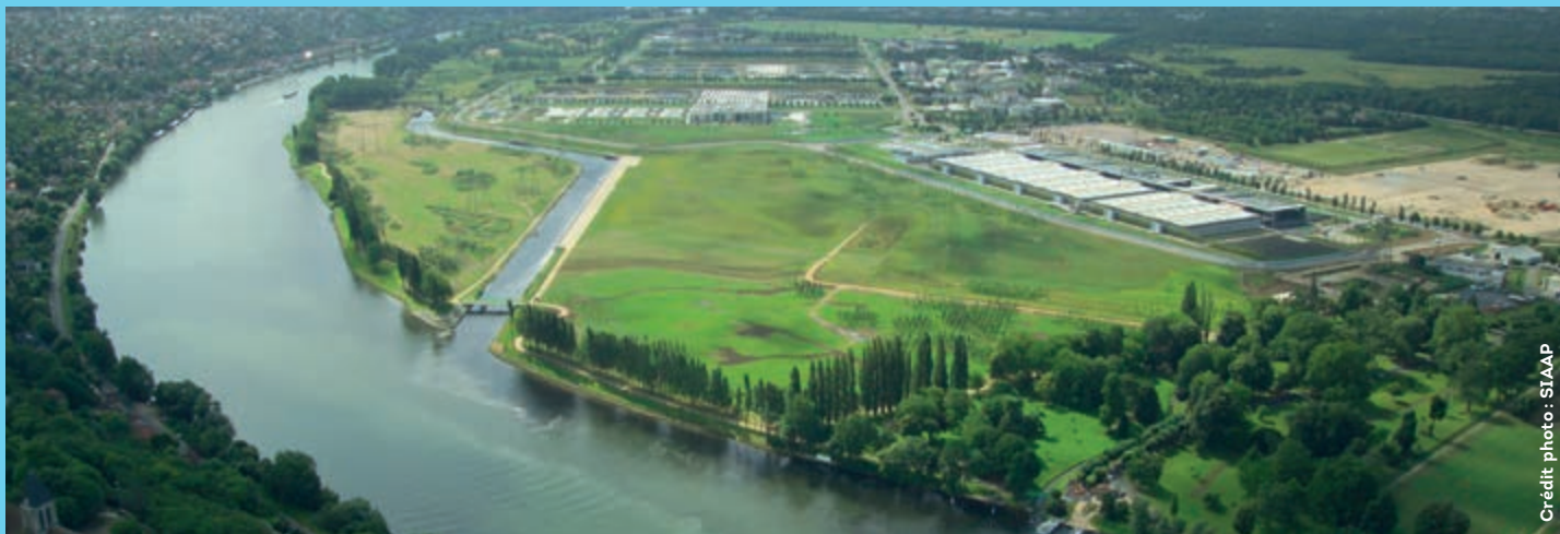
Usine de dépollution des eaux usées Seine aval
